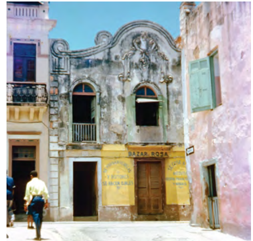
El Bazar Rosa es un edificio de fines del siglo XIX en la calle Luna frente al callejón Tamarindo.
