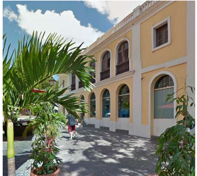
Figura 41. Fachada lateral actual del teatro
