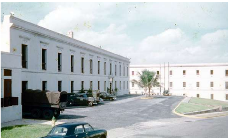
Figura 7. Antiguo Cuartel de Ballajá.
