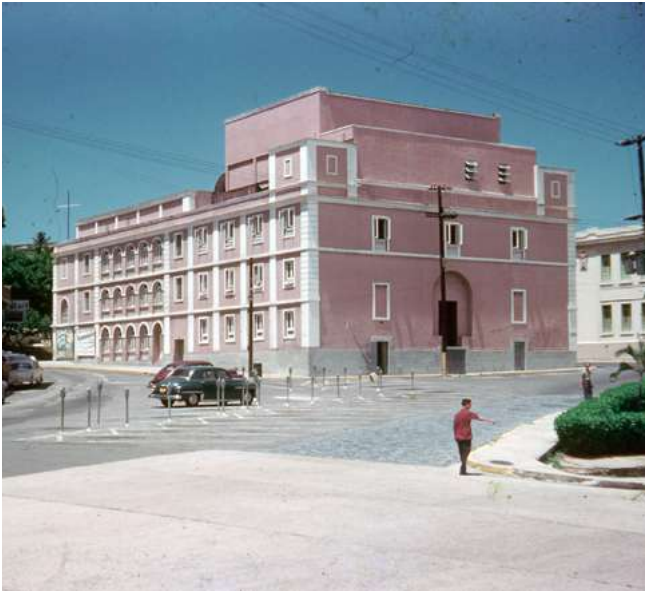
Figura 40. El teatro municipal es obra del siglo XIX. Fue intervenido en el siglo XX y transformada su fachada
