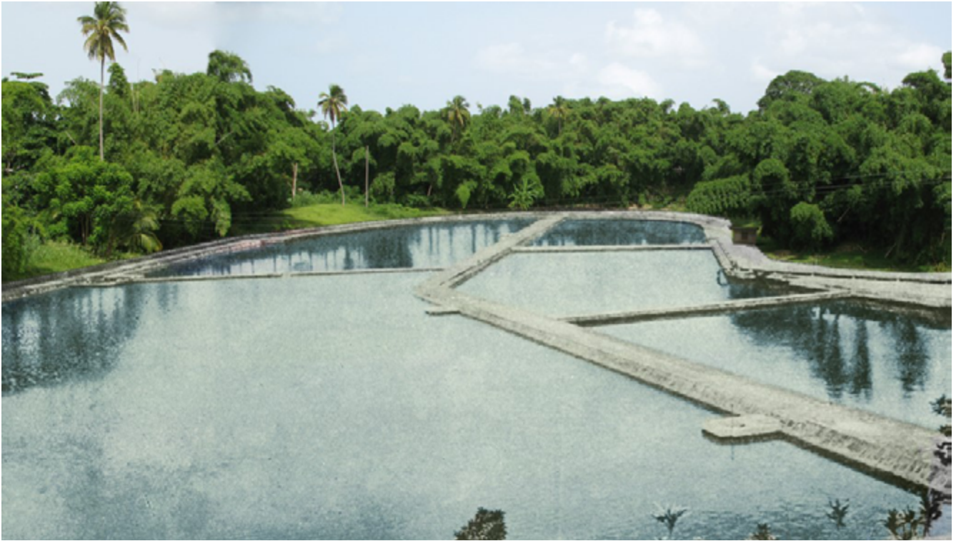
Pasado y presente. Montaje de foto coloreada de los estanques de decantación del acueducto en 1912 sobre el bosque que lo enmarca en la actualidad. Cortesía de Aníbal Sepúlveda Rivera.
