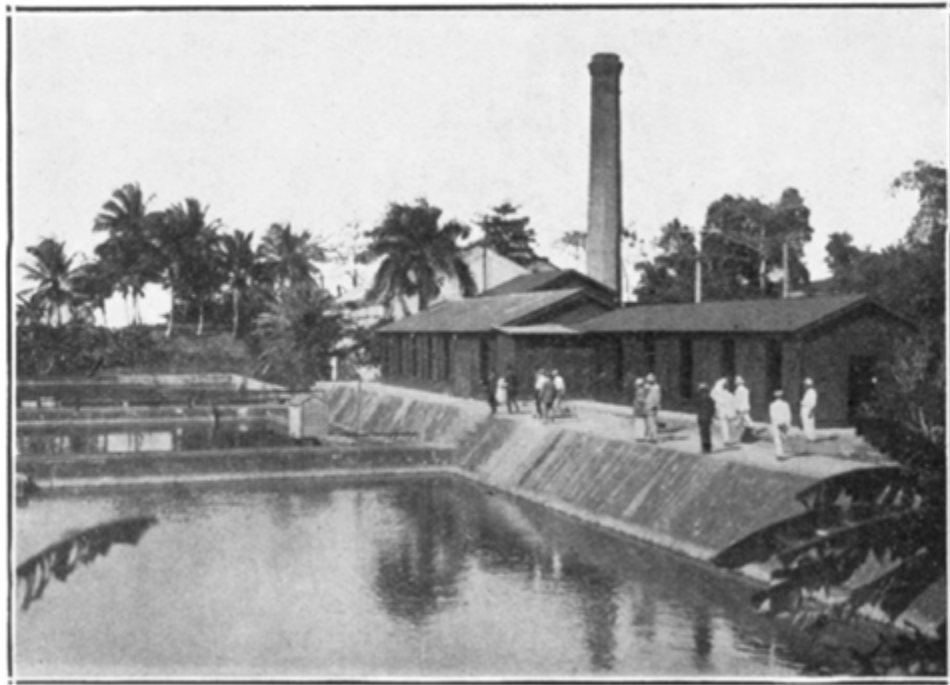
Tres de los grandes tanques y la casa de máquinas, donde han sido instalados doce enormes filtros, con capacidad para filtrar diariamente 500.000 galones de agua.
