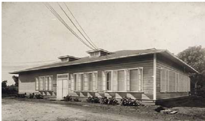
1919c Estudio en Hato Rey, AGPR. Aquí ubicaba la planta eléctrica. Vean el indispensable tendido eléctrico.
