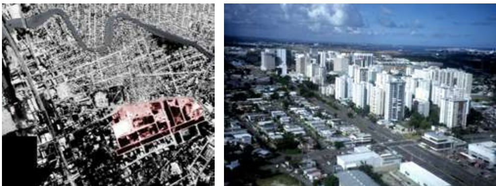
Urbanización Piñero en construcción, 1962, DTOP / Condominios de la Urbanización Piñero, 2000, Colección de Pedro Martínez
