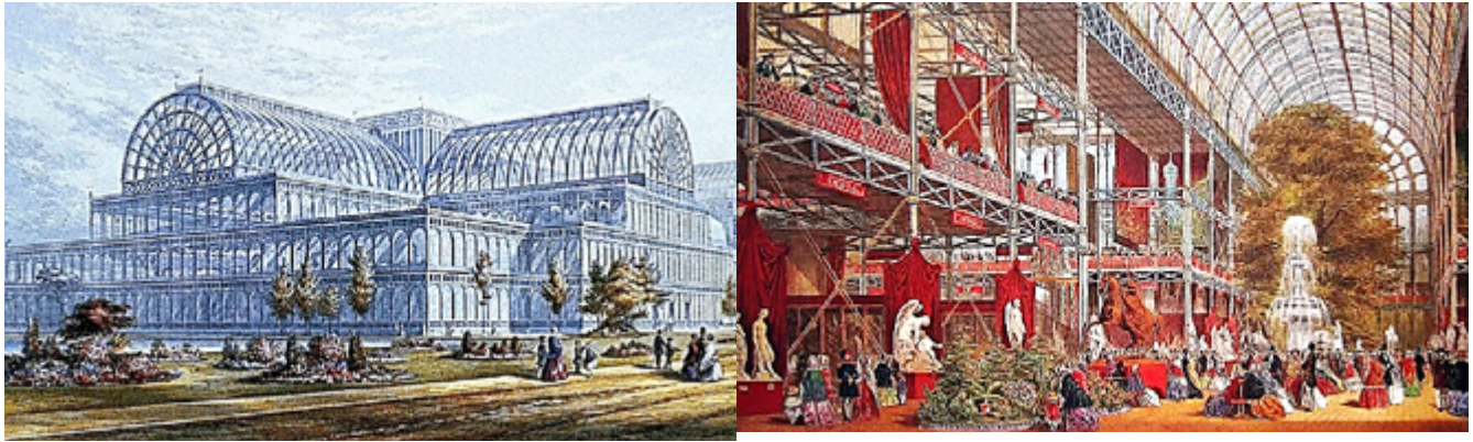
Vistas exterior e interior del “Palacio de Cristal” en Hyde Park, Londres. Edificio principal de la exposición de industrias de 1851.
